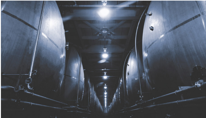
Füllstandmessung in Tanks
